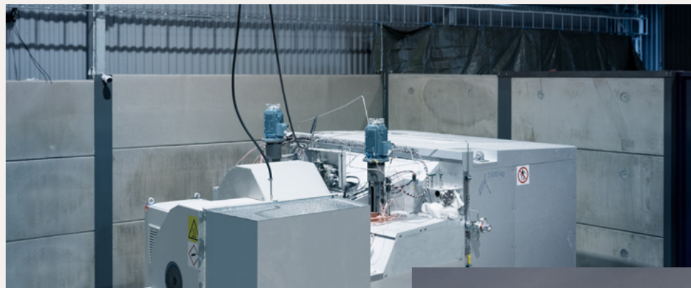
TES.POD-enheter sätts samman i kluster för att förse anläggningar med rätt kapacitet.
